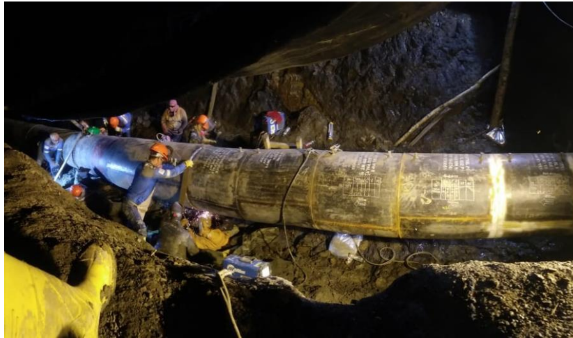
Reparación de fisuras por empuje de terreno (Riesgo geodinámico)
