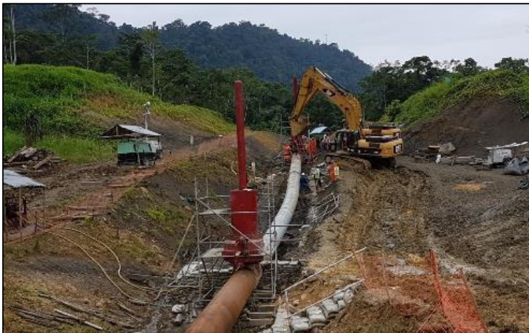
Distensionado de tubería y reemplazo de sector de tubería
