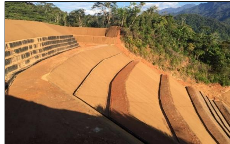
Estabilización de taludes
