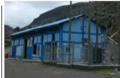
CH Shagua = 1.1 MW
