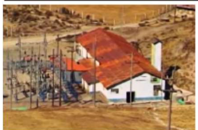
CH San José = 1.4 MW
