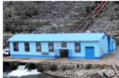
CH Huanchay = 1.6 MW
