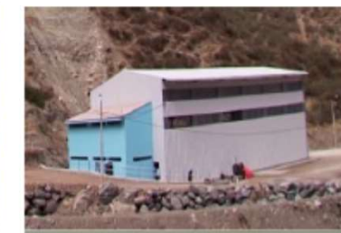
CH Baños V = 9.2 MW
